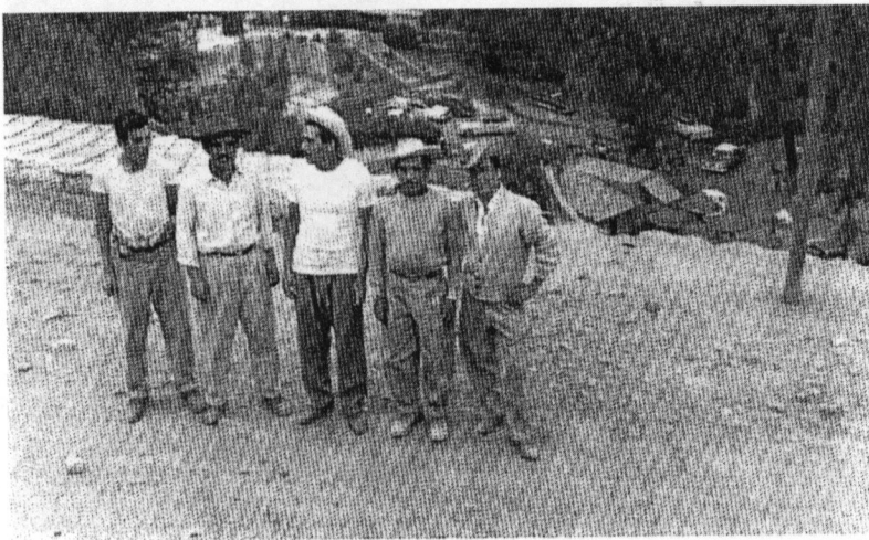
Construcción de la nueva escuela (José Azueta) en el barrio
