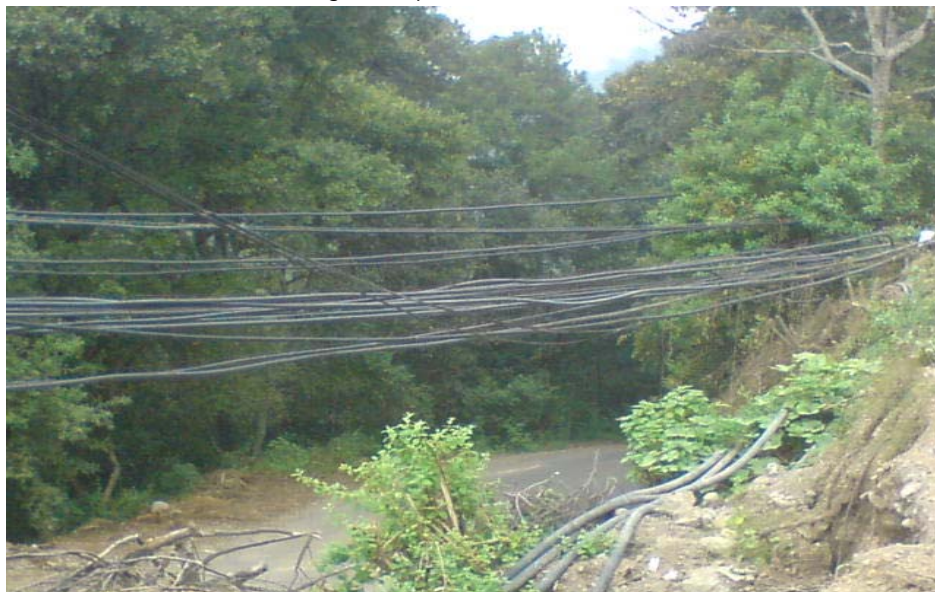
Foto: mangueras que se encuentra en la comunidad de Hueyapan
