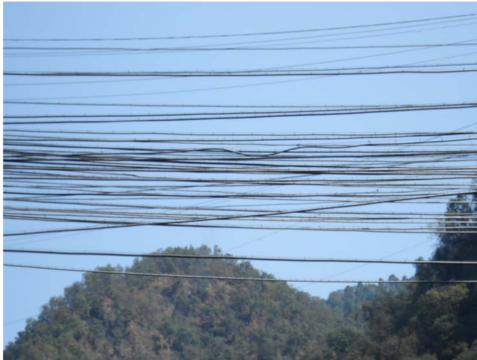
Foto: mangueras que atraviesan toda la barranca del río Amatzinac
