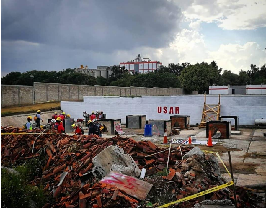
Figura 3. Curso de búsqueda y rescate en estructuras colapsadas, UEBPC-Jalisco (2018), Archivo Personal.
