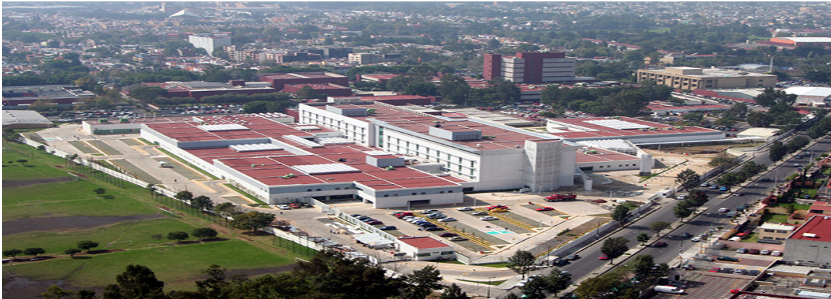
Figura 3: Vista Panorámica del Hospital General Regional #2.
