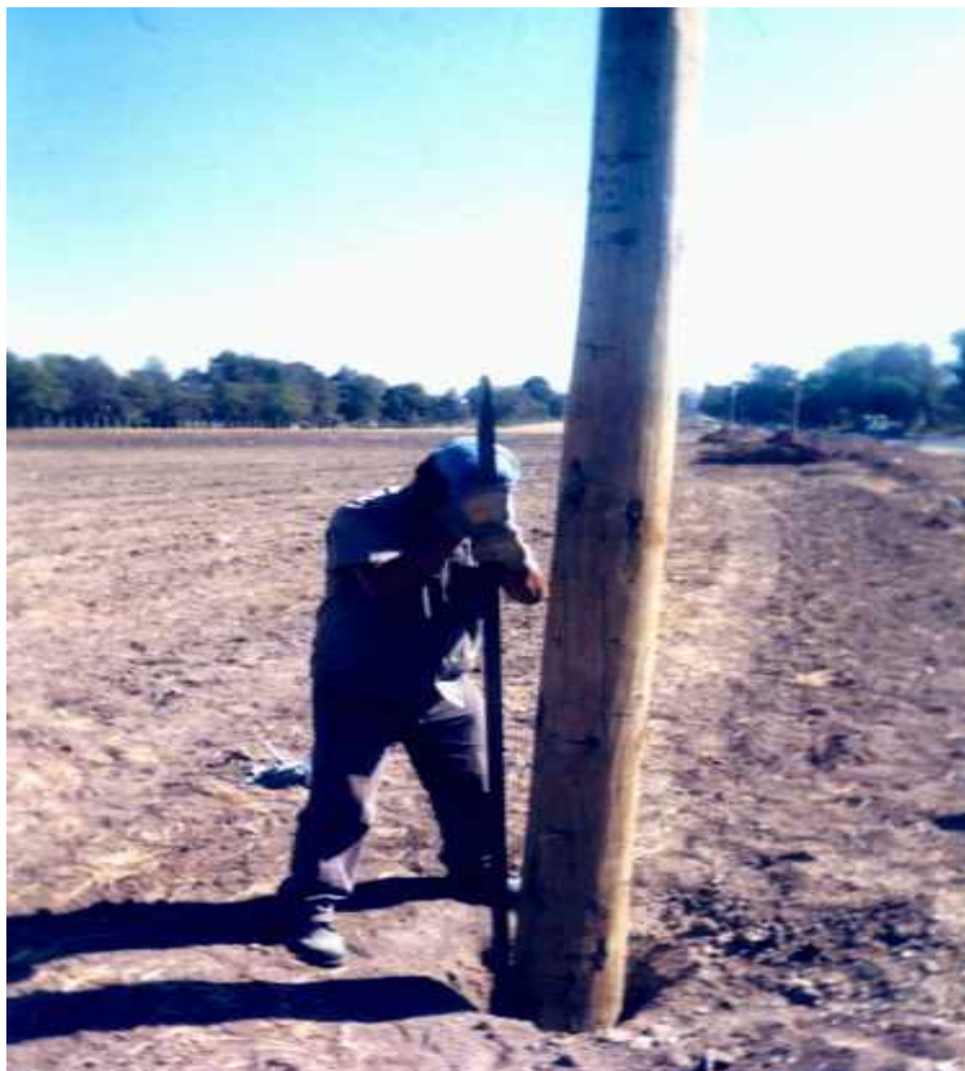
FOTOGRAFÍAS: OBRA DE INSTALACIÓN AEREA DE 2000 MTS. DE CABLE DE FIBRA ÓPTICA EN LA CARRETERA TEXCOCO-TLAXCALA, PROGRAMA DE EMERGENCIA REALIZADO EN FEBRERO DE 2002, DEBIDO A LA RUPTURA DE LA LÍNEA SUBTERRÁNEA PRINCIPAL POR EL TRABAJO DE AMPLIACIÓN DE LA AUTOPISTA.
