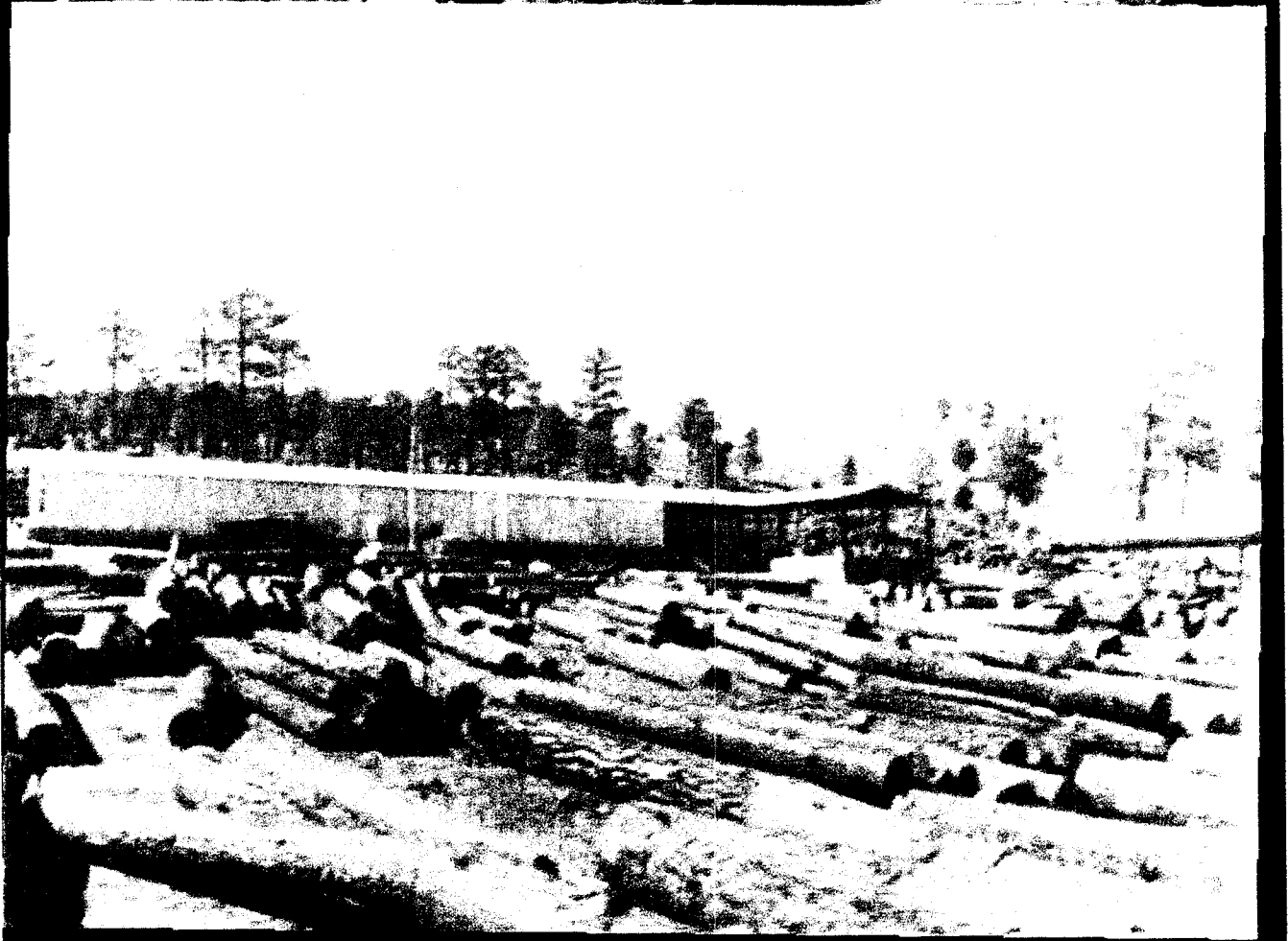
FIGURA 62.- READECUACION DE ASERRADEROS POR PARTE DE PROFORTARAH. CIRCA 1974 (TOMADO DE PRODUCTOS FORESTALES DE LA TARAHUMARA, 1976: 61)
