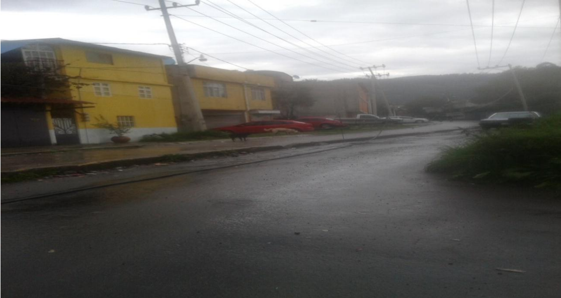
Ilustración 0-6 Estado de algunos tramos de la ciclopista rural de Tlalpan
