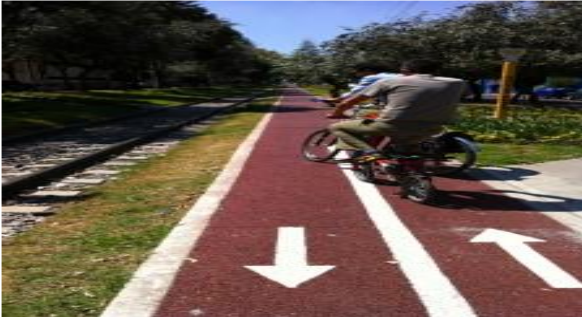
Ilustración 0-7 Algunos tramos sobre Ferrocarril de Cuernavaca fuerón construidos en paralelo
