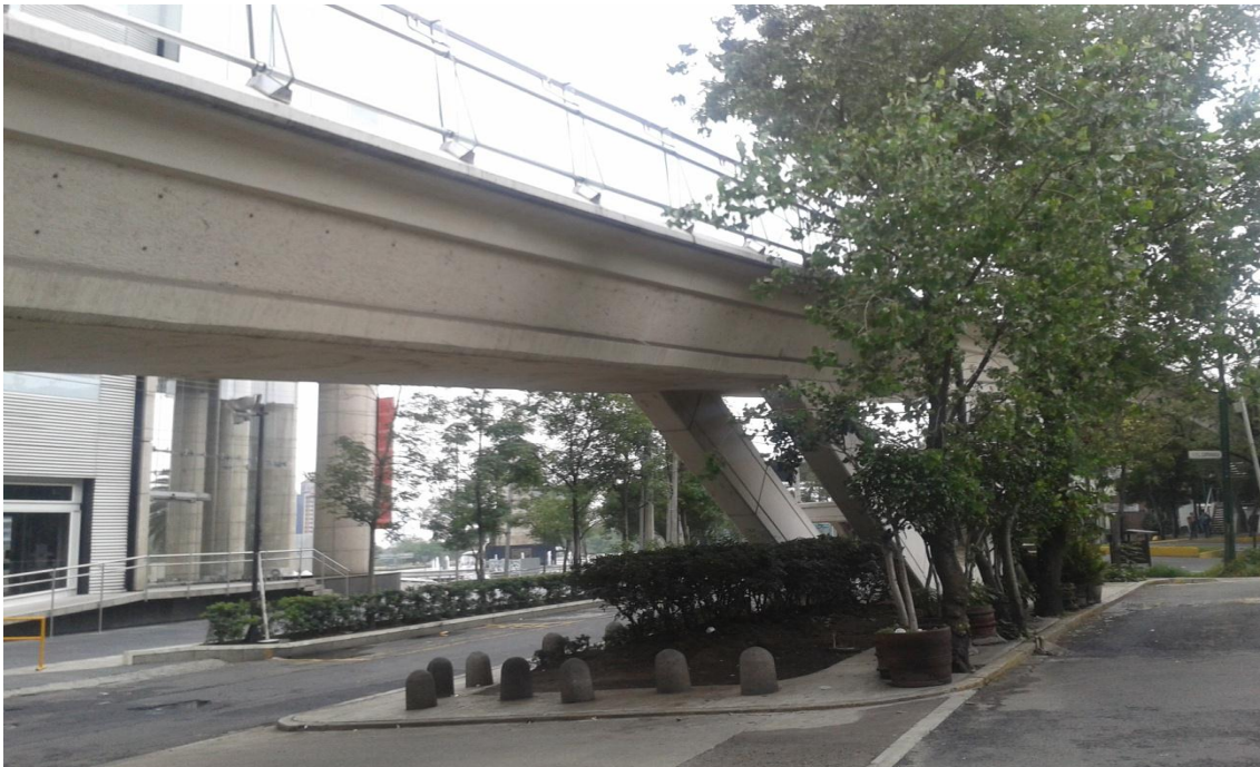
Ilustración 0-2 Tramo sobre Ferrocarril de Cuernavaca y Reforma
