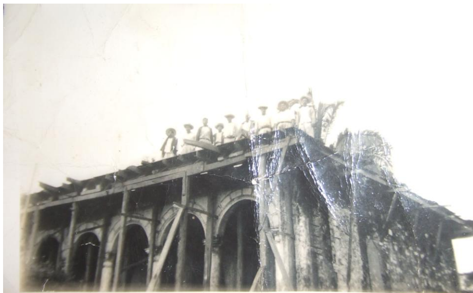
Foto: Construcción de la primaria del centro de Tetelilla.
