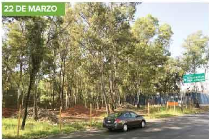
ZONA VERDE. Antes de que iniciara la construcción del puente, la zona contaba con muchos árboles, entre ellos 20 eucaliptos.
