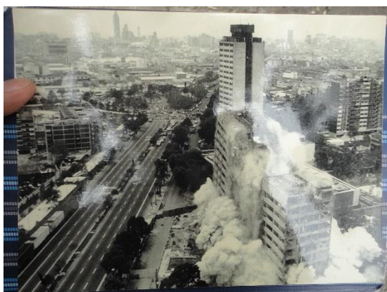
Imagen 23. Registro mostrado en uno de los recorridos por el interior del conjunto urbano. En la foto se muestra la torre habitacional que fue demolida, en el terreno, ahora se encuentra el Huerto Tlatelolco. Diego Vargas 25/05/2018
